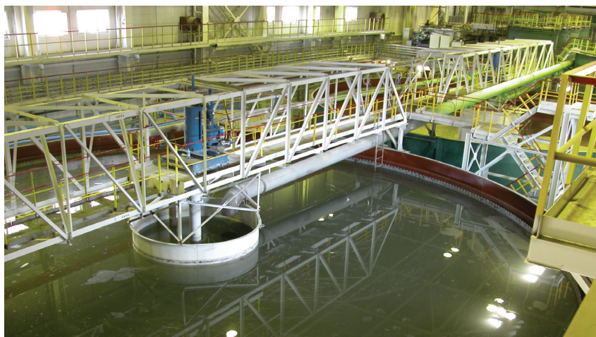
Радиальный сгуститель с центральным приводом
